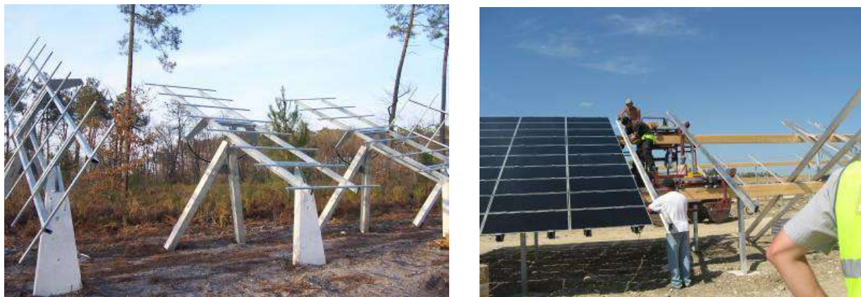
Photographie 4 : Montage des supports de la technologie « trackers » (à gauche), montage de modules sur des supports fixes (à droite) (Source : EDF Renouvelables)
