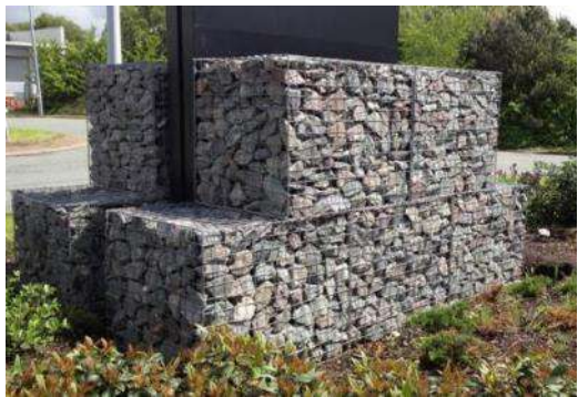
Figure 17 : Exemple de muret en gabion (Source : TCS Geotechnics)
