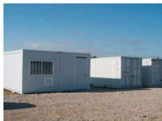
Photographie 2 : Installation de la base-vie (Source : EDF Renouvelables)
